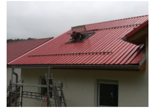
6 Neue Dachflächenfenster und Schneefänger wurden eingebaut.
