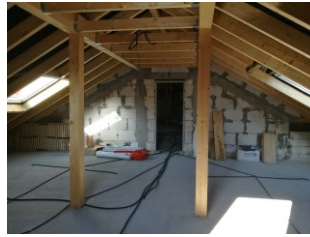
Stromleitungen bevor der Estrich eingebracht wird.
