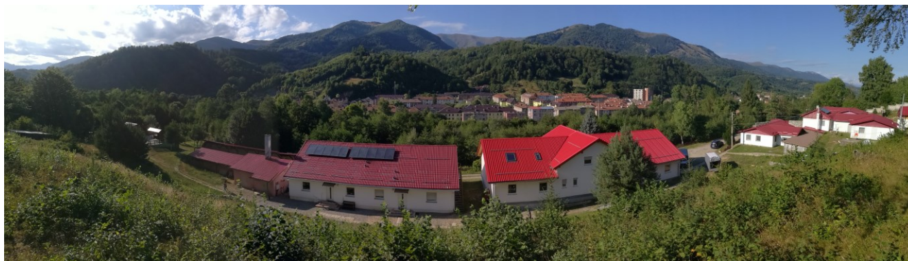
Gelände mit dem Neubau ↑ 19.August 2021
