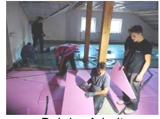
Bei der Arbeit Aufenthaltsraum DG
