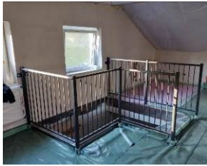
Das neue Geländer
